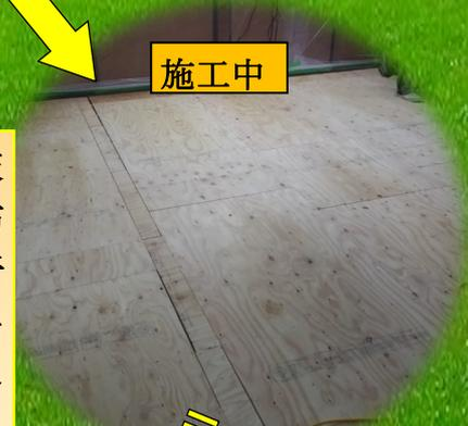
和室の床が腐敗した為、床下の骨組みを交換して、防湿シートを敷きました！断熱材を敷き詰めて、フローリングにリフォームしました！次世代エコポイントも利用し、住宅も懐も、あったかーく、なりました。
